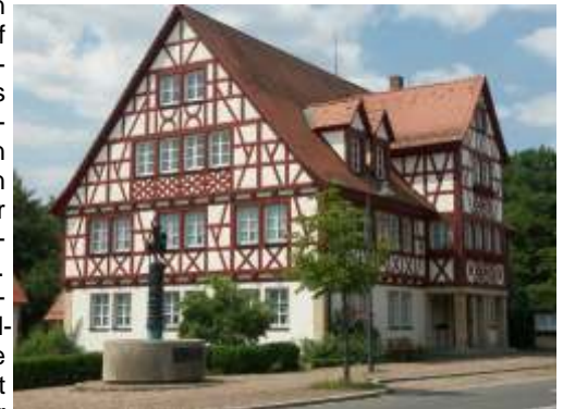
Das Rathaus in Igensdorf mit dem St.Georg-Brunnen
