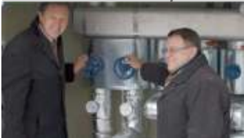
Das neue Nahwärmenetz in Benk (Lkr BT) spart 300 Tonnen CO 2 im Jahr.
